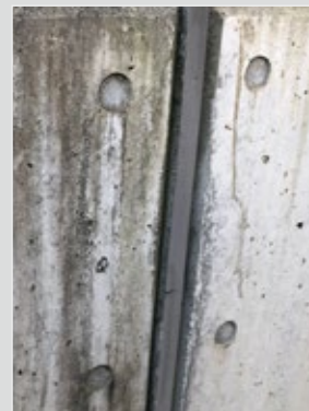
樹脂塗料が経年変化で膨らみ、剥がれ、黒沁み汚れの出たコンクリート
