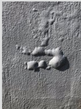
樹脂塗料が経年変化で膨らみ、剥がれ、黒沁み汚れの出たコンクリート
